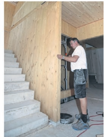
Zimmermann Dirk Schubert hat alles im Blick: Bis auf Bodenplatte und Treppe ist das Gebäude aus Holz.
