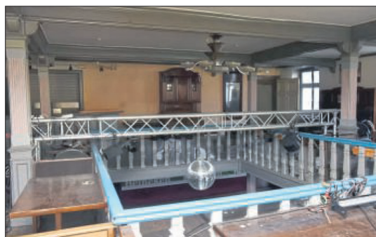
Noch ist die Empore der Kneipe „Anno 1888“ zu erkennen. Zwischen Erdgeschoss und Empore wird eine Decke eingezogen, so dass die ganze Etage von der Malschule genutzt werden kann.
