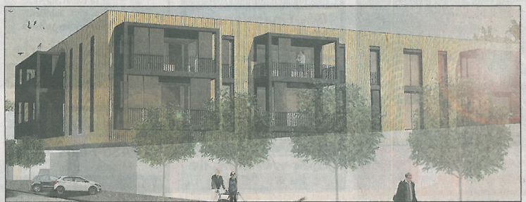
Im Bild der Entwurf des Gebäudes über dem Orthopädischen Zentrum am Mühlenweg in Bad Westernkotten. Hier sollen auf dem bestehenden Flachbau zwei Stockwerke in Holzrahmenbauweise errichtet werden. Alle 28 Ferienwohnungen erhalten einen Balkon und bekommen einen „Bademantelgang“ zu den Thermen.
